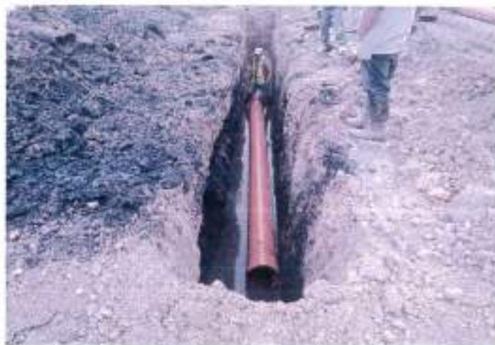
INSTALACION DE TUBERIA SANITARIA DE PVC DE 12" DE DIAMETRO
