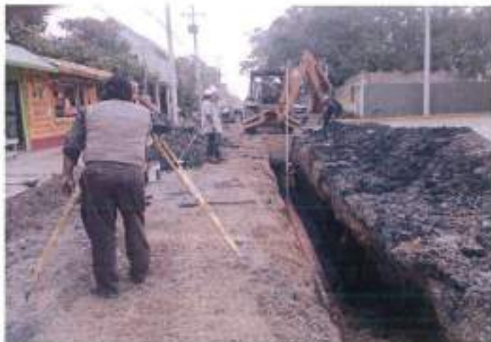
TRAZO Y NIVELACION EN EL AREA DE TRABAJO
