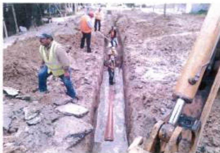
INSTALACION DE TUBERIA SANITARIA DE PVC DE 18" DE DIAMETRO
