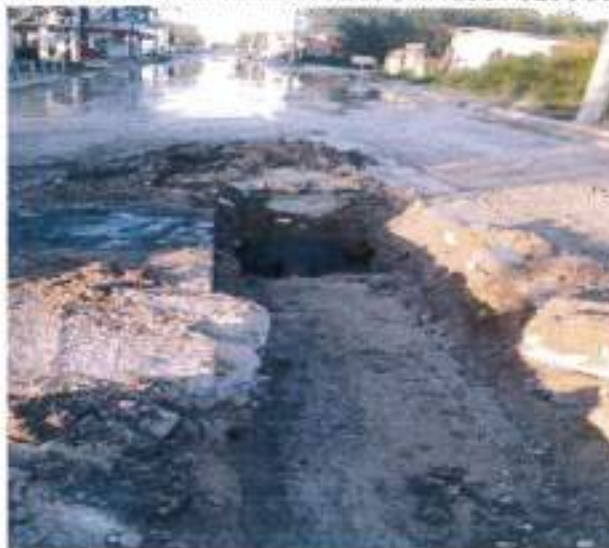
INTERCONEXION EN TUBERIA DE 20 CM A LOS POZOS DE VISITA
