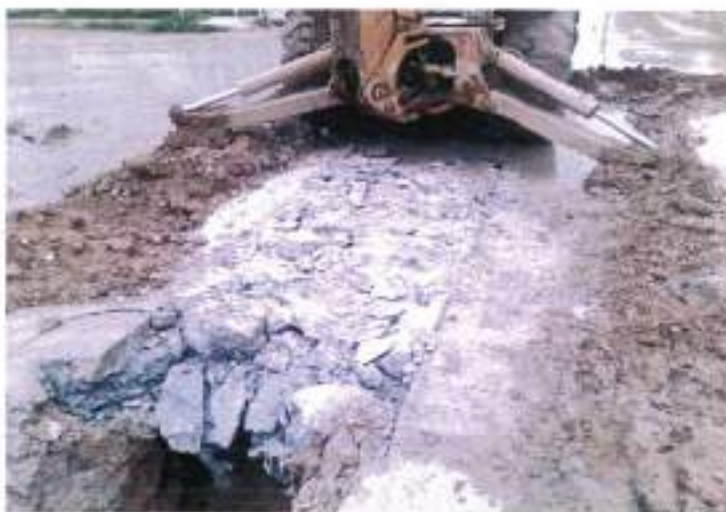
RUPTURA Y DEMOLICION DE PAVIMENTO ASFALTICO
