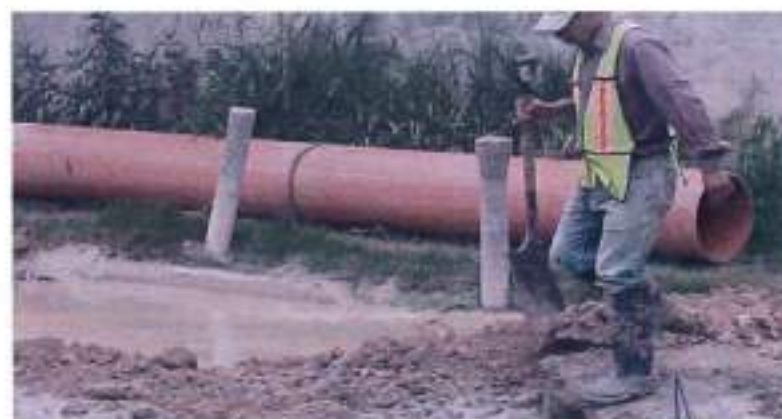
ACARREO DE TUBERIA DE PVC DE 18" DE DIAMETRO
