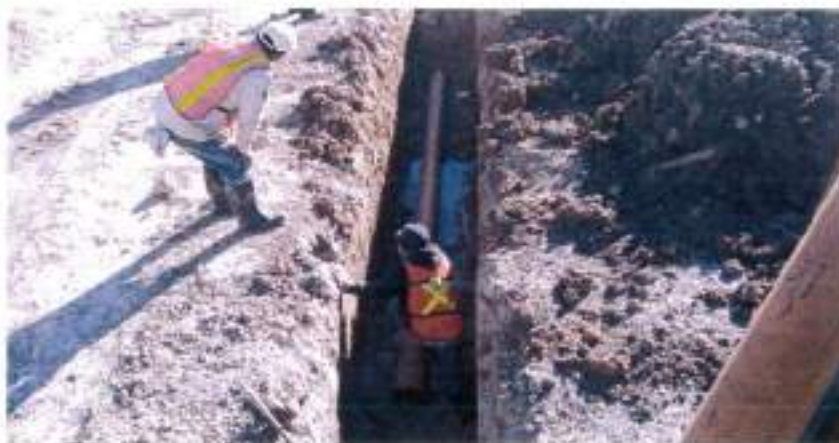
INSTALACION DE TUBERIA SANITARIA DE PVC DE 8" DE DIAMETRO
