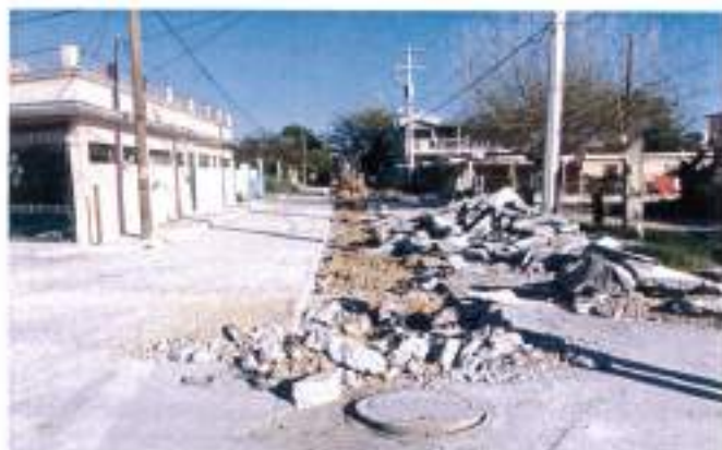
TRAZO Y NIVELACION TOPOGRAFICA
