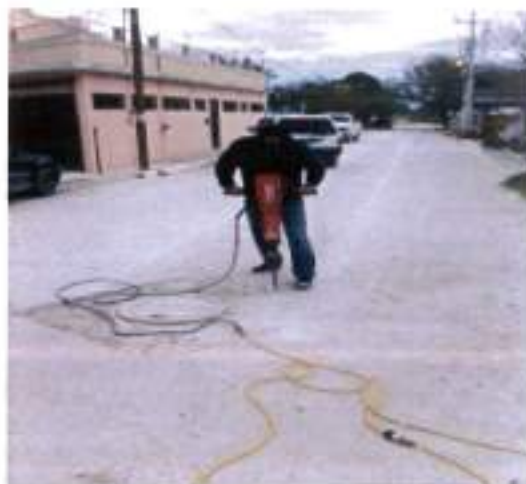
RUPTURA Y DEMOLICION DE PAVIMENTO CONCRETO
