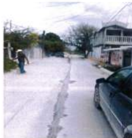
TRAZO Y CORTE CON CORTADORA DE DISCO EN PAVIMENTO DE CONCRETO
