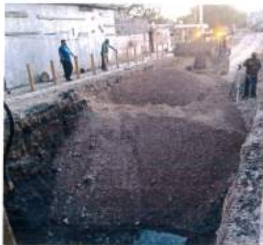
RELLENO EN ZANJA COMPACTADO CON MATERIAL PRODUCTO DEL BANCO
