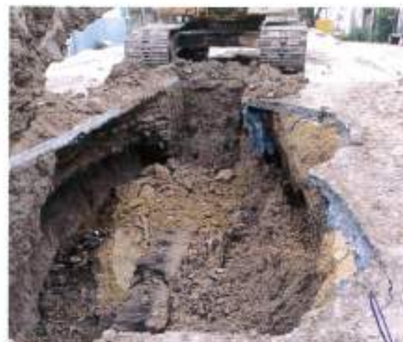
EXCAVACION CON EQUIPO PARA ZANJAS EN MATERIAL COMUN EN SECO EN ZONA B DE 0.00 HASTA 6.00 MTS DE PROFUNDIDAD
