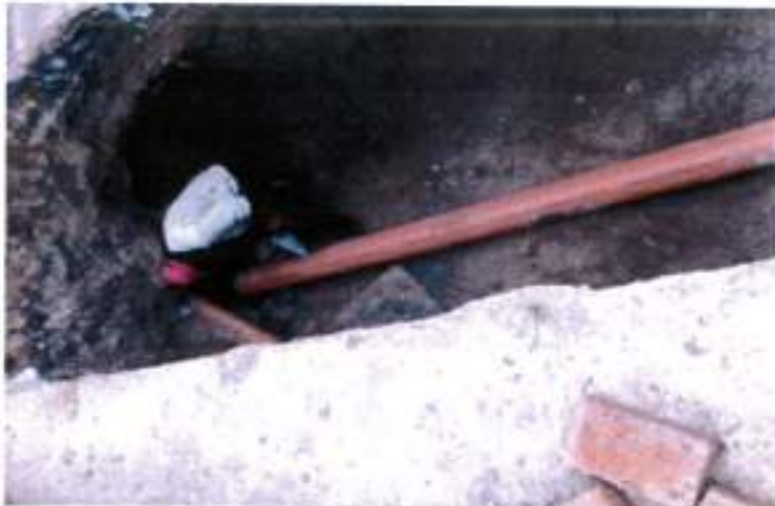
INSTALACION DE TUBERIA SANITARIA DE P.V.C DE 8" DE DIAMETRO
