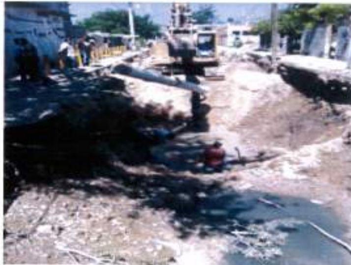
INSTALACION DE TUBERIA SANITARIA DE P.V.C DE 16" DE DIAMETRO
