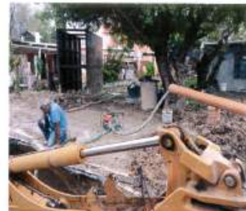
BOMBEO DE ACHIQUE CON BOMBA AUTOCEBANTE DE 3' DE DIAMETRO Y 6 H.P.
