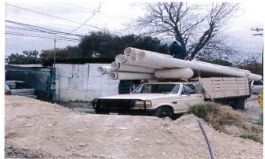
ACARREO DE TUBERIA P.V.C DE 16" DE DIAMETRO
