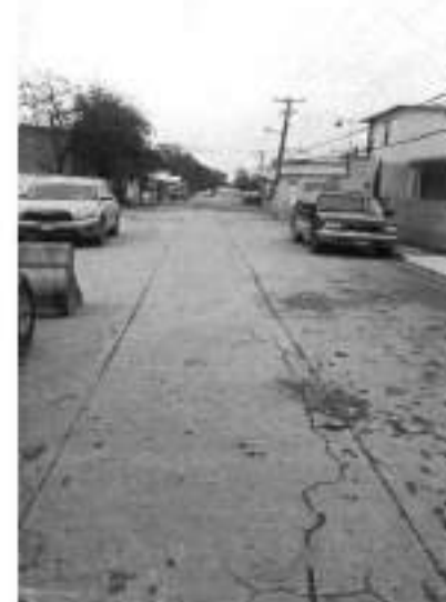
TRAZO Y CORTE CON CORTADORA DE DISCO EN PAVIMENTO ASFALTICO
