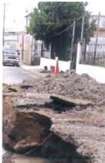
RUPTURA Y DEMOLICION DE PAVIMENTO ASFALTICO
