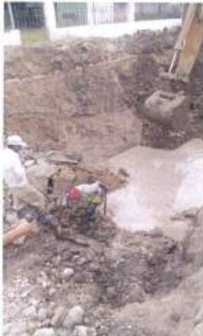
INSTALACION DE TUBERIA PVC SANITARIO SERIE METRICA (SERIE 20 ) 8" DE DIAMETRO
