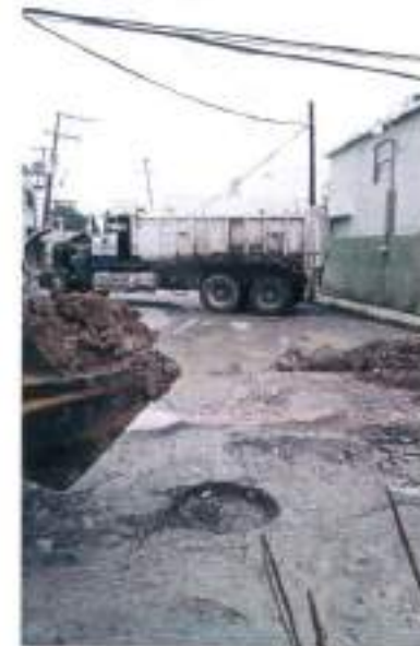
ACARREO PRIMER KILOMETRO PRODUCTO DE EXCAVACION EN CAMION INCLUYE CARGA MECANICA
