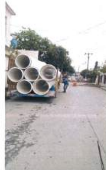
ACARREO DE TUBERIA DE PVC SANITARIO NOVAFORT DE 30" DE DIAMETRO
