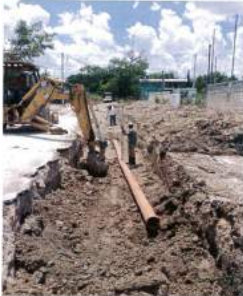
ACARRÉO DE TUBERIA DE PVC DE 8" DE DIAMETRO
