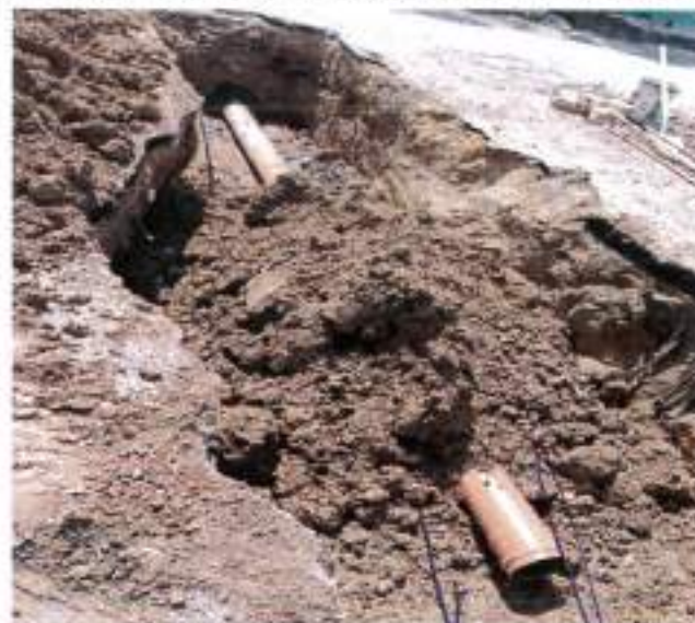
INSTALACION DE TUBERIA PVC SANITARIO SERIE METRICA (SERIE 20 ) 8" DE DIAMETRO
