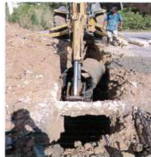
EXTRACCIÓN DE TUBERIA CONCRETO DAÑADA DE 76 CM DE DIAMETRO
