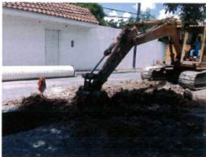
ACARREO DE TUBERIA DE PVC SANITARIO NOVAFORT DE 24" DE DIAMETRO
