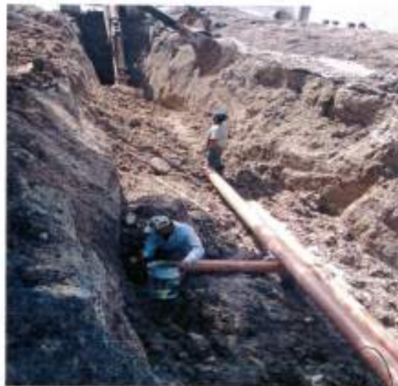
REPOSICION DE CONEXIÓN DESCARGA DE (PVC) INCLUYE MANO DE OBRA
