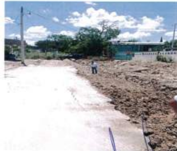
RELLENO EN ZANJAS COMPACTADO AL 90 % PROCTOR CON MATERIAL PRODUCTO DE BANCO
