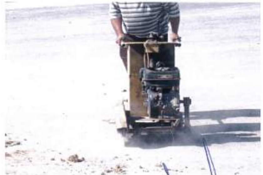
TRAZO Y CORTE CON CORTADORA DE DISCO EN PAVIMENTO ASFALTICO
