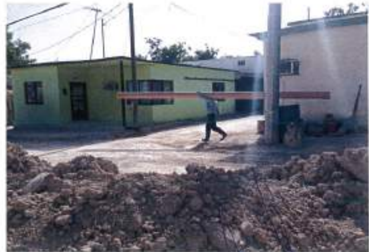
ACARREO DE TUBERIA DE PVC DE 8" DE DIAMETRO
