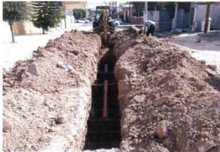
INSTALACION DE TUBERIA SANITARIA DE PVC DE 8" DE DIAMETRO
