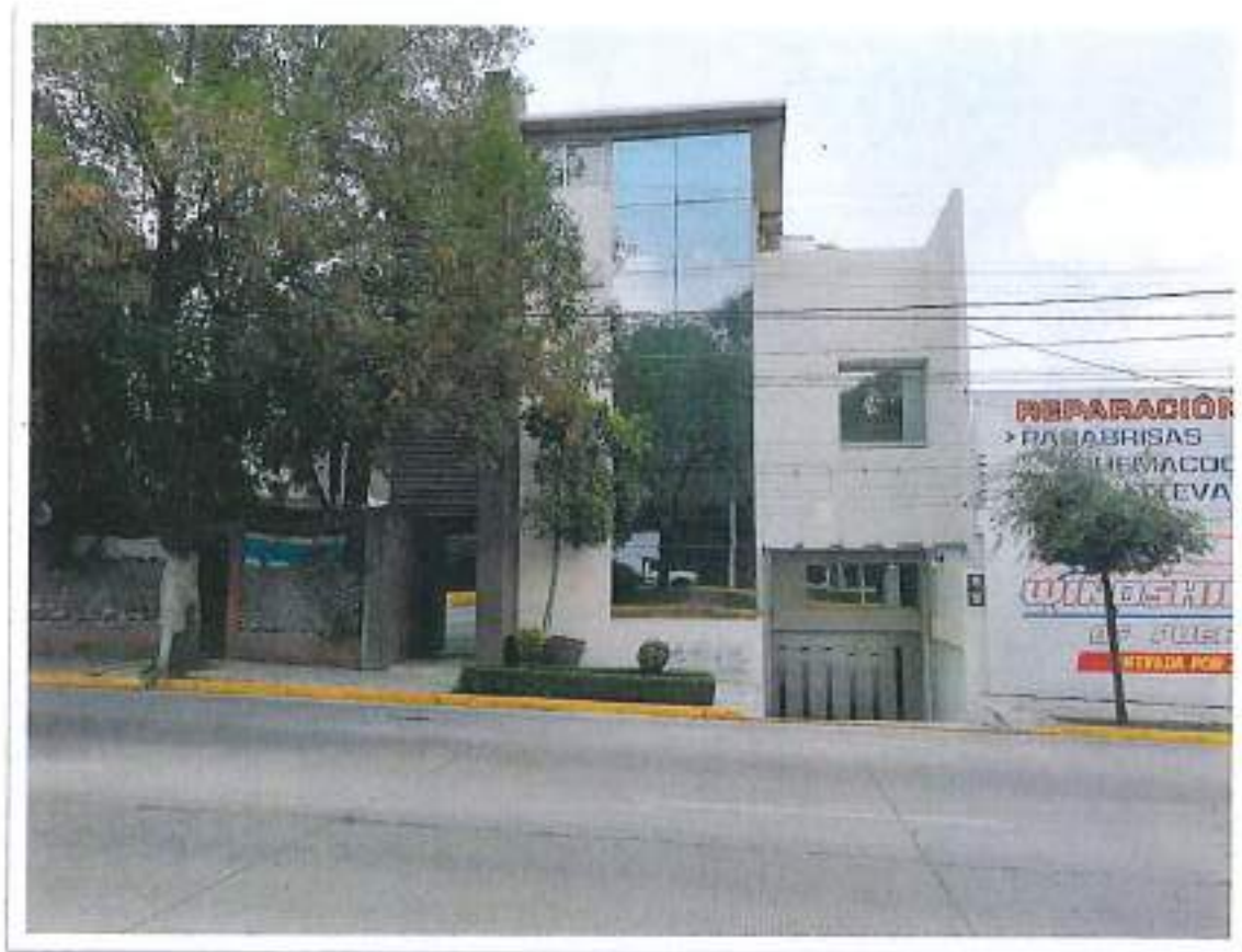
FIGURA 1.-FACHADA PRINCIPAL DEL EDIFICIO
